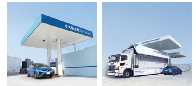
北大水素ステーション (大阪府茨木市)
