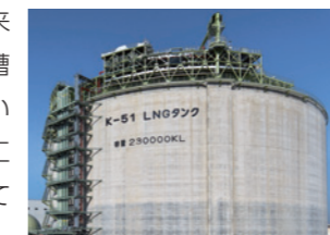
泉北製造所 第一工場5号LNGタンク外観
