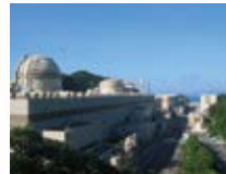
原子力軽水炉プラント工事
