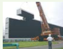
大型映像装置の設置
