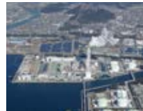
火力発電プラント工事
