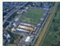
水環境プラント工事
