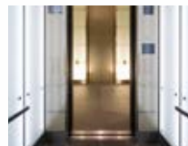
昇降機据付工事
